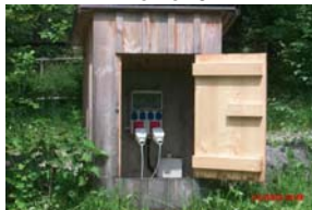
Stromverteiler
